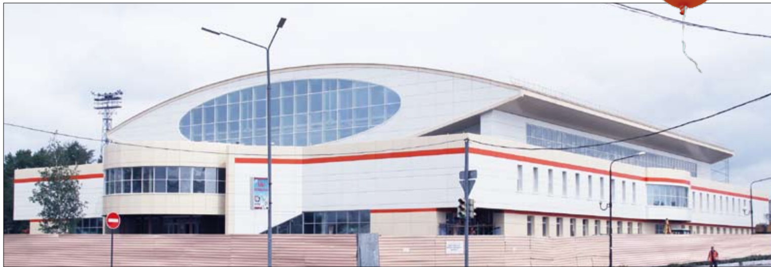
Наружные работы на Ледовом дворце почти закончены.
