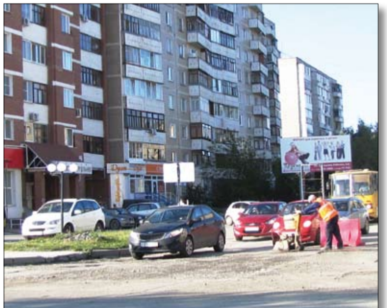
Даже погода благоприятствует дорожным работам.
